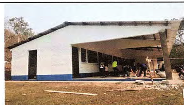
Foto 5: Reparación de puertas y Cambio de chapas realizadas.
