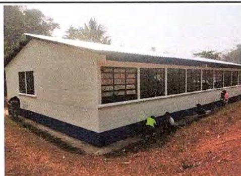
Foto 2: Sustitución de la pintura finalizada
