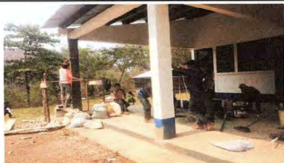
Foto 3: Reparación de Columnas del corredor terminada en su totalidad
